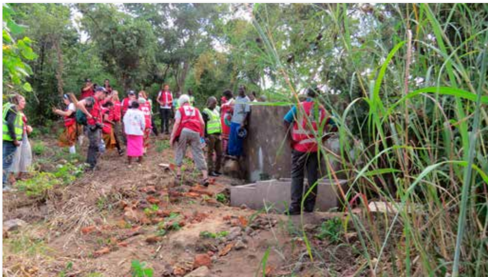
Besøg ved vandprojekt - 30.000 liter vandtank
